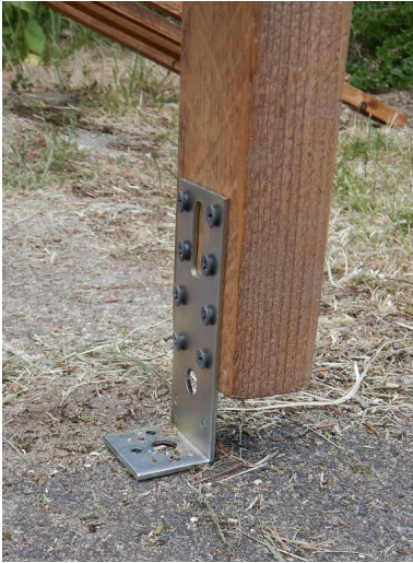
Abbildung 5: Metallfuß aus Winkel
