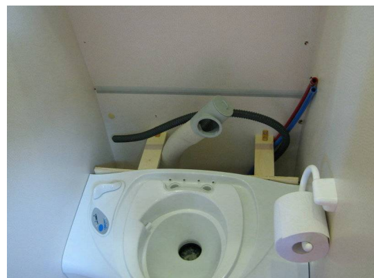
Abb. 3: nach Entfernung des Original-Waschbeckens
