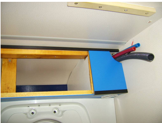
Abb. 7: Holzkonstruktion und Abdeckung rechts
